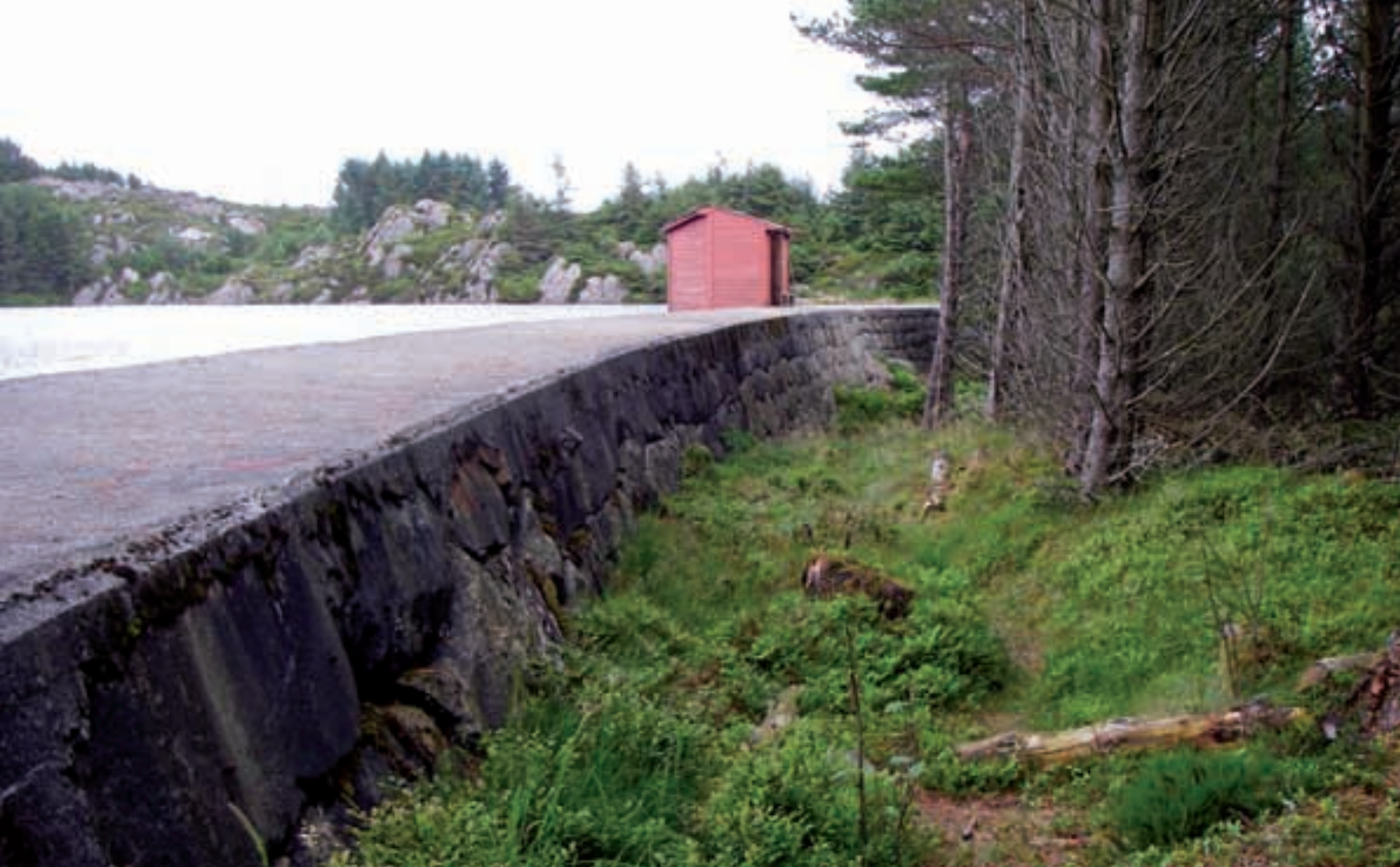
Demning Litlavatnet, Skudeneshavn
