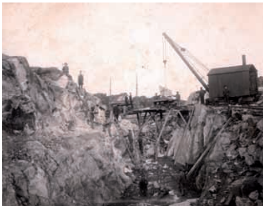
Kanalen under bygging
