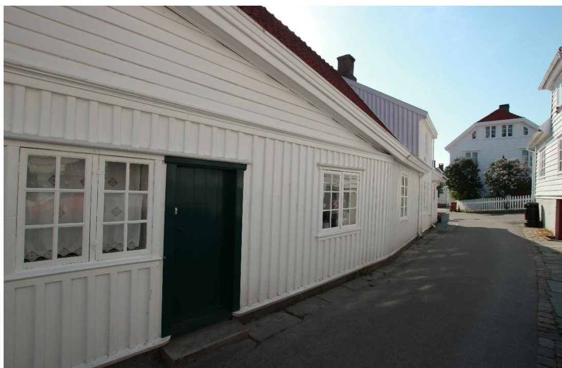
Figur 42. Skudeneshavn. Søragedå 23. Sett fra sydøst. Den nyeste delen av huset er hitenfor knekken i fasaden mot gata. Huset er nå ensfarget hvitmalt. Foto: j. Brønne. Mai-juni. 2018
