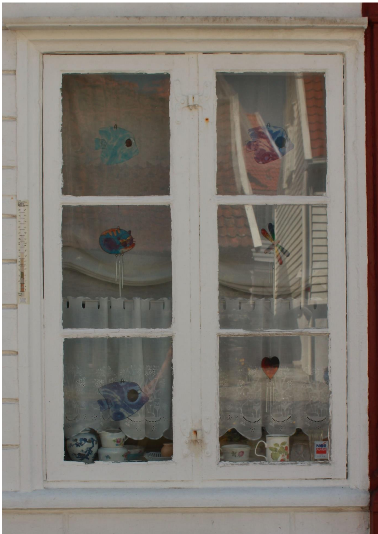
Figur 110. Skudeneshavn. Veibellsbakken 5. Vinduet øst for hoveddøra i hovedfasaden. Alle vinduene i 1. etasje bortsett fra et på nørdestfasaden er to-ramsvinduer hengslet på midtposten. Geriktene har ikke utsparinger for å kunne hekte av vinduene, likevel mener undertegnede at alle geriktene er opprinnelige. Brystningslista danner undergerikt på vinduene. Foto: J. Brønne. Mai–juni 2018.
