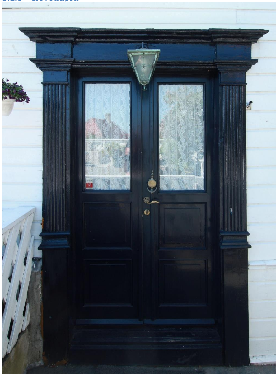
Figur 29. Skudeneshavn. Søragadå 13. Hoveddøra. Døra er trolig den opprinnelige, med en meget flott klassisk omramming med kannelerte pilastre. Døra er ikke undersøkt, men med stor sannsynlighet følger døras fargehistorie malinglagene på dørromrammingen. Foto: J. Brønne. Mai-juni 2018
