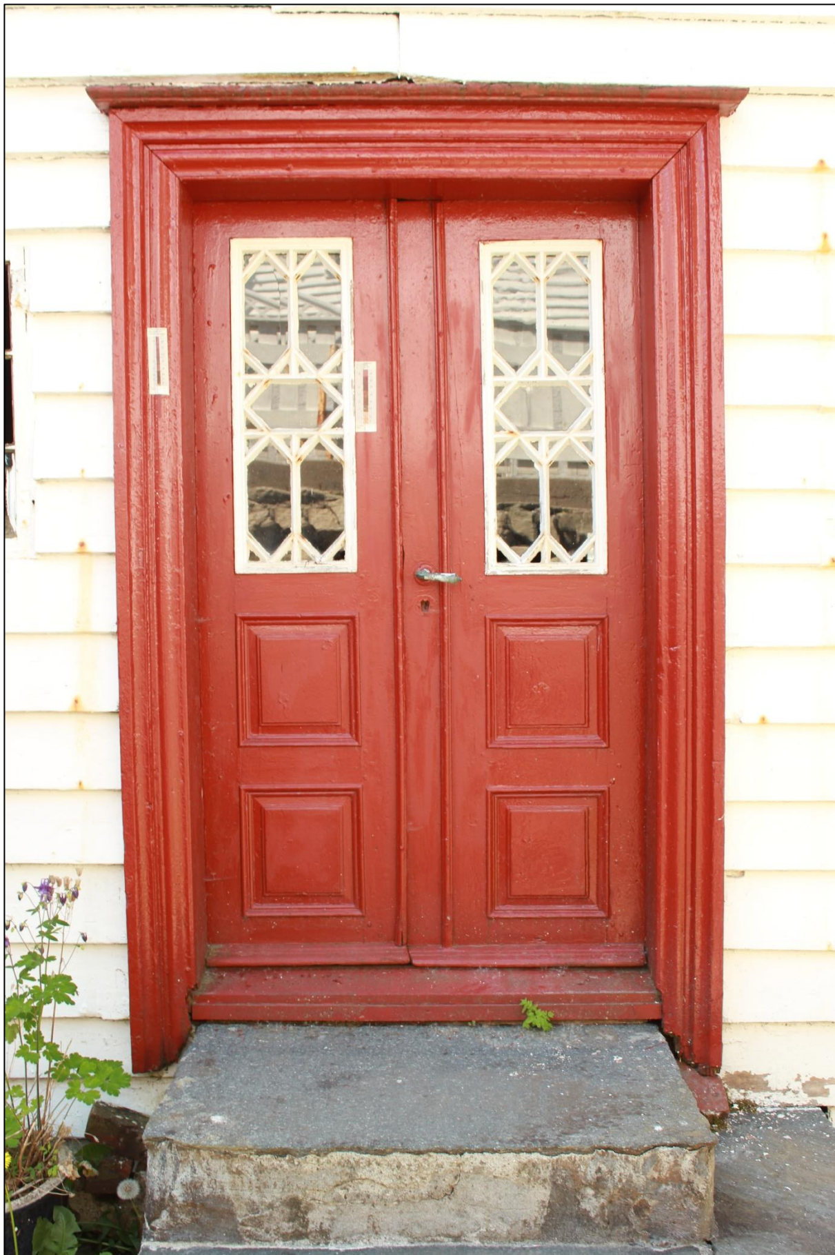
Figur 77. Skudeneshavn. Søragedå 63. Hoveddøra mot Søragedå. To- fløyet innadslående dør. Opprinnelige glass og ornamenter i øverste fyllinger. Døra er noe nyere enn huset, og er trolig satt inn i perioden 1845 – 1860. Døromrammingen er samtidig med døra. Foto: J. Brønne. Mai-juni 2018.
