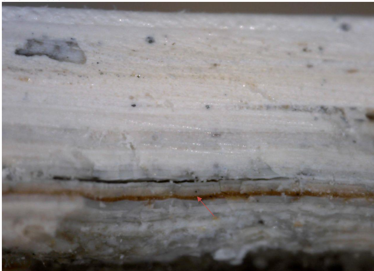
Søragadå 13.Vindu. Nordvegg.170X
