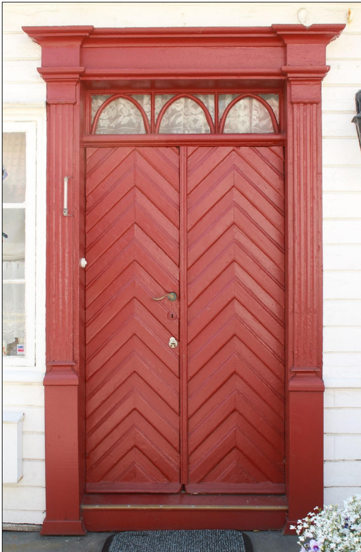
Figur 105. Skudeneshavn. Veibellsbakken 5. Hoveddøra mot nordøst med omramming. Døra er sekundær, trolig fra tiden etter siste verdenskrig. Omrammingen er opprinnelig, med kraftig profilert bekroning og pilastre med konkave kanneleringer. Døra har et vakkert, forseggjort overlysvindu, noe som ikke er vanlig i Skudeneshavn. Foto: J. Brønne. Mai-juni 2018.
