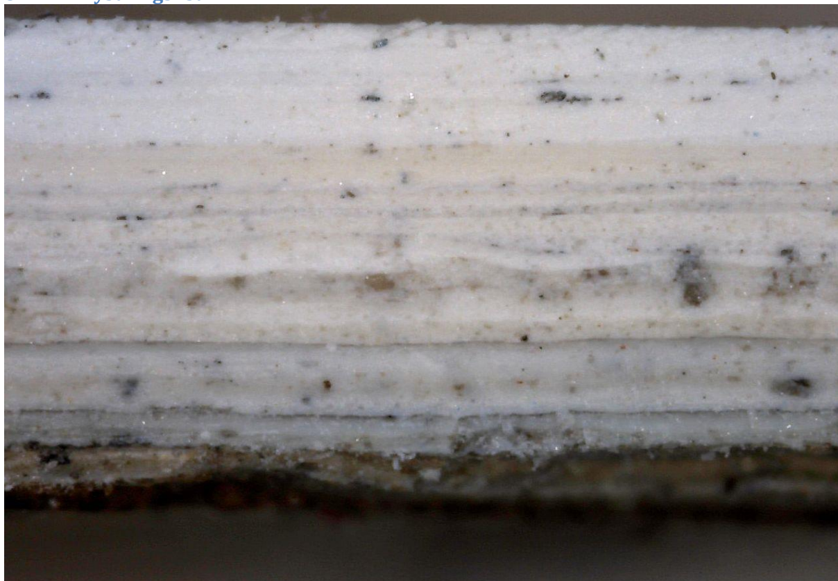
Søragadå 13. Etasjeskiller/Brystningslist. 65X
