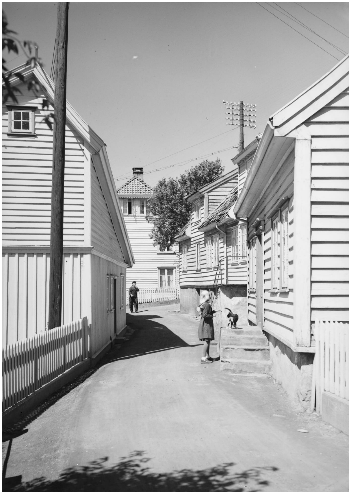
Figur 36. Skudeneshavn. Søragedå 23. Sett fra sydøst. Det ser ut til at huset da hadde blitt malt med hvit panel og vinduer, med en liten kontrast på vindusgeriktene. Se gavlvinduet. Foto: Ukjent. 1951. www.tidsmaskinen
