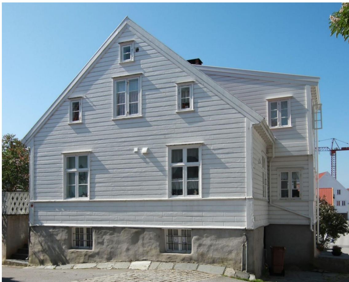
Figur 9. Skudeneshavn. Søragadå 13. Sett fra nord. Tilbygget i to etasjer mot nordvest er nevnt i branntaksten fra 1878, og er trolig bygget like før dette. Foto: J. Brønne. Mai-juni 2018
