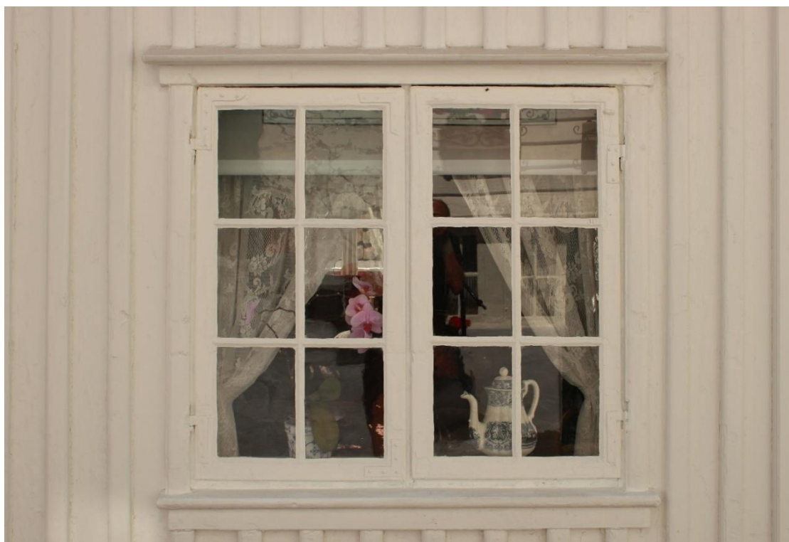
Figur 47. Skudeneshavn. Søragadå 23. Vindu i den nyere delen fra 1887. To-ramsvindu, med 2 x 3 glass i hver ramme. Begge rammene er hengslet på sidekarmene. Opprinnelige vindusgerikter. Foto: j. Brønne. Mai-juni. 2018
