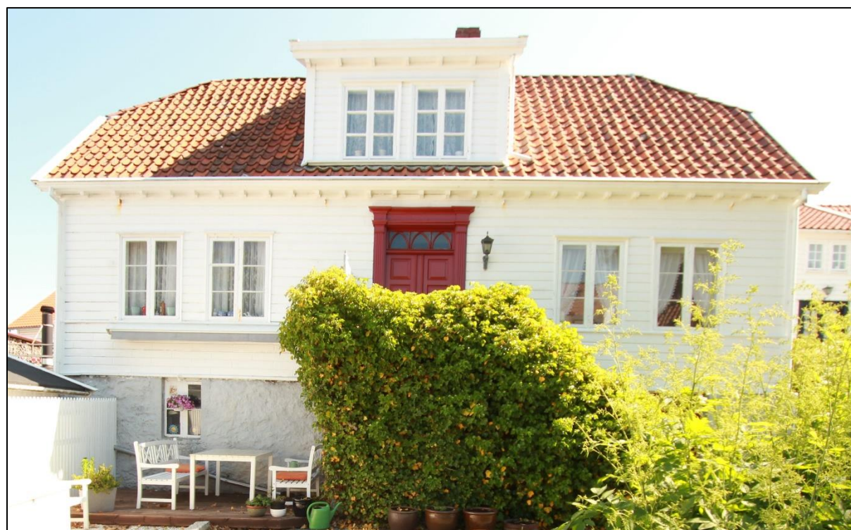
Figur 98. Skudeneshavn. Veibellsbakken 5. Sett fra sydvest. Arken er sekundær, trolig fra 1970- åra. Tilpassingen er pent utført. Foto: J. Brønne. Mai-juni 2018.
