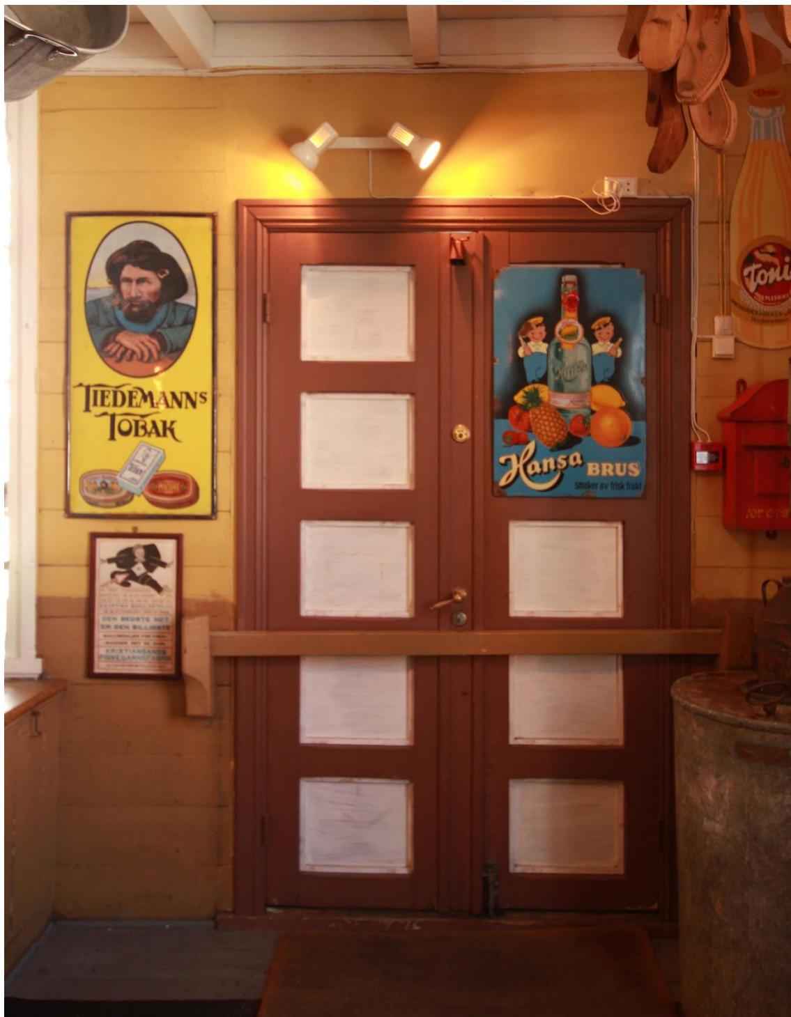
Figur 116. Skudeneshavn. Holmen 16. Kramboden. Inngangsdøra fra nordvest. Døra er ny, og har bare det nåværende malinglaget. Foto J. Brønne. Juni 2018.
