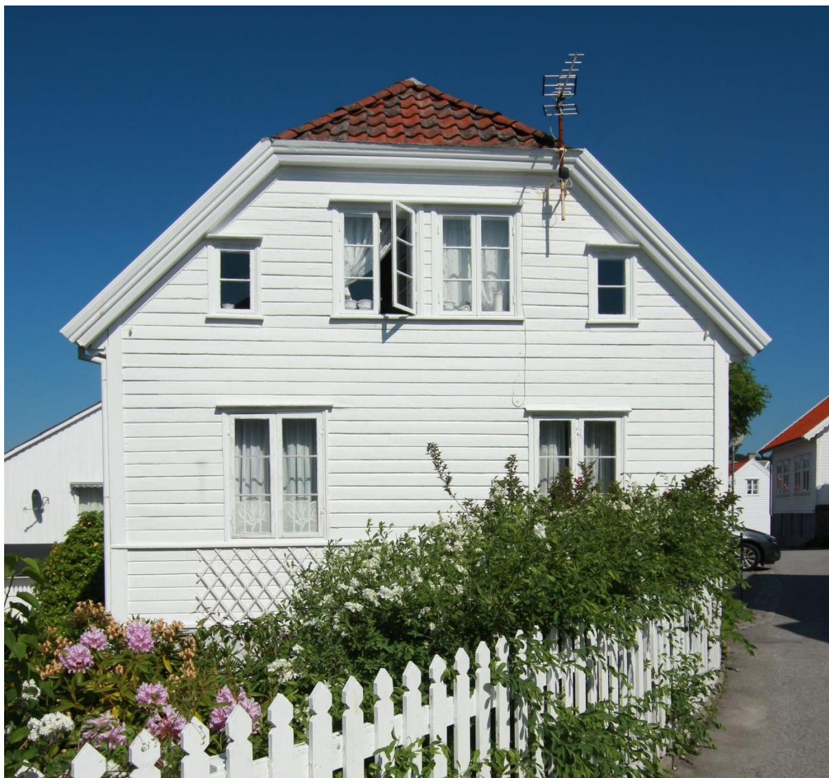
Figur 96. Skudeneshavn. Veibellsbakken 5. Sett fra syd. Vinduene i 2. etasje er hengslet på sidekarm, noe som tilsier at de ikke er opprinnelige. Foto: J. Brønne. Mai–juni 2018.
