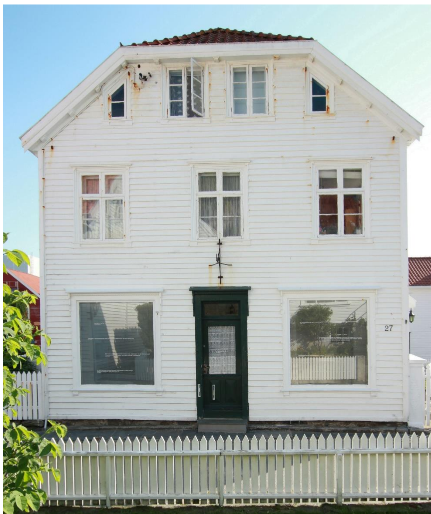
Figur 55. Skudeneshavn. Søragedå 27. Sett fra nordøst. Fasaden mot Søragedå. Vinduene i 2. og 3. etasje er de opprinnelige. Vinduene og døra i 1. etasje er fra siste del av 1800- åra. Foto: J. Brønne. Mai-juni 2018.
