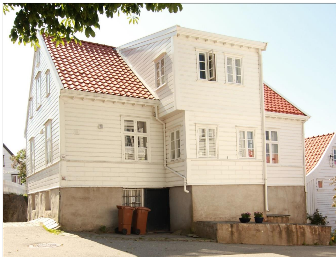
Figur 10. Skudeneshavn. Søragadå 13, sett fra sydøst. Panel, vinduer og gerikter er opprinnelige. Foto: J. Brønne. Mai-juni 2018.
