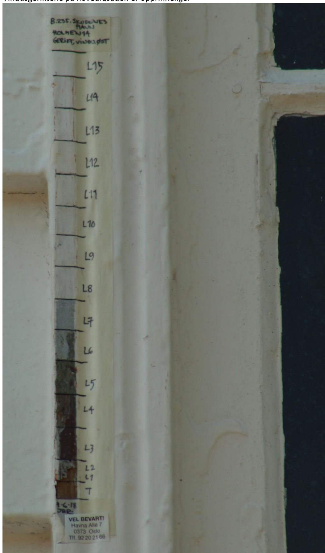
Figur 90. Holmen 14. Fargelagsavdekking på vindusgerikt. Foto: J. Brønne. Mai-juni 2018.
