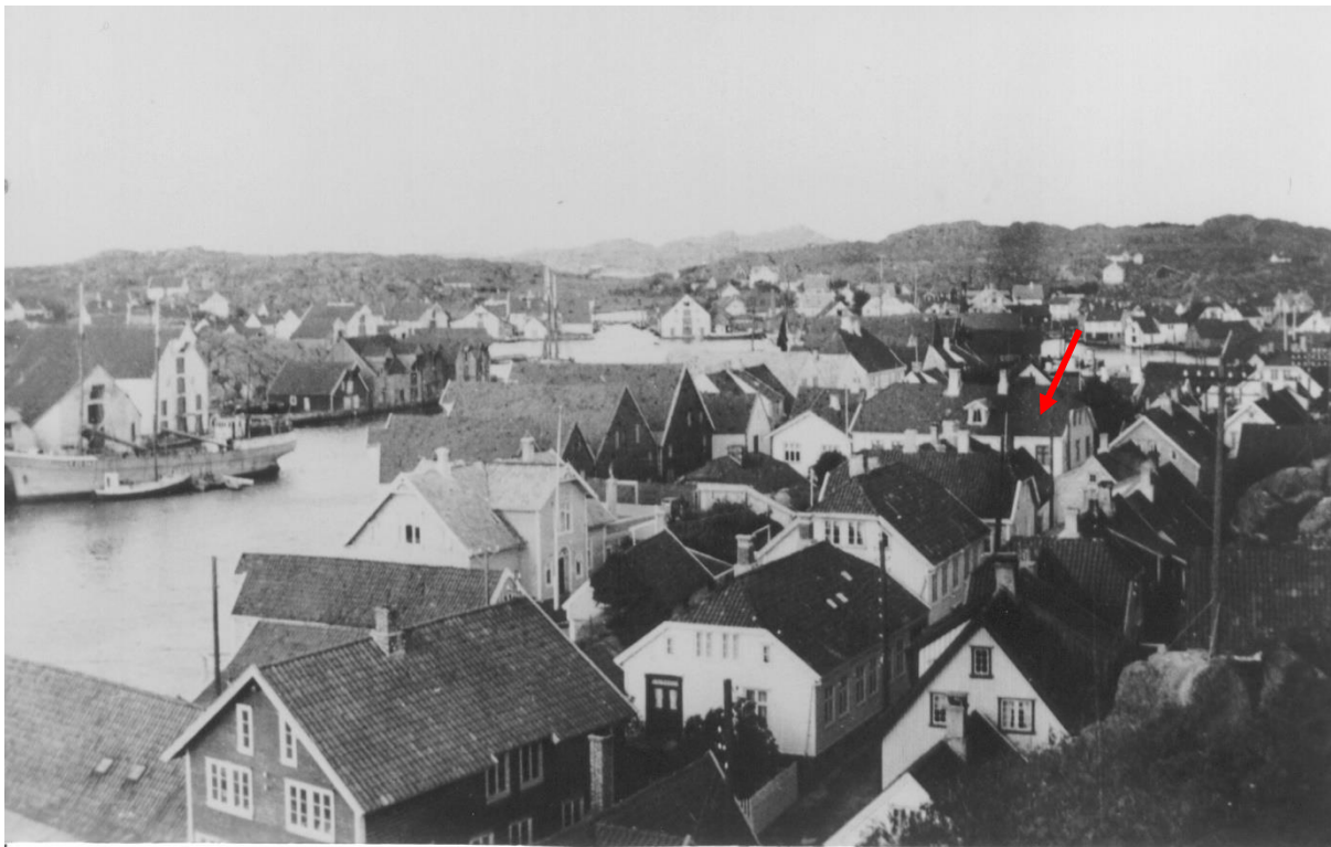
Figur 50. Skudeneshavn. Søragedå 27. Bygningen (Rød pil) har ark på taket og mørke vinduer. Bildet er datert 1927, men er med stor sannsynlighet eldre. Sammenlikn dette bildet med figur 52, som er datert 1920, hvor huset er ensfarget hvit? Hvis datering 1927 er korrekt, er de to bildene med datering 1920, figurene 52 og 53 feildatert, og skal da trolig være datert 1930? Foto. Ukjent. www.tidsmaskinen
