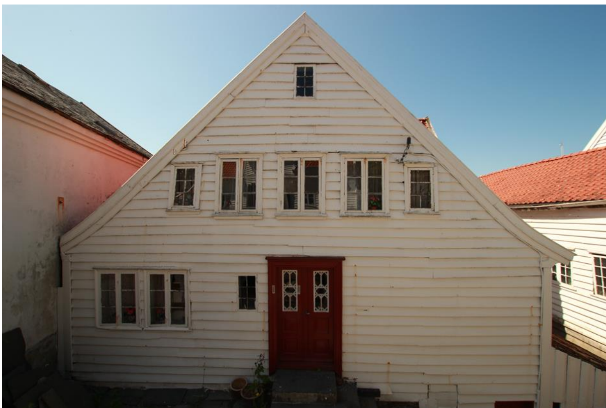
Figur 68. Søragedå 63. Sett fra nordøst, med inngangsdøra. Døra er noe nyere enn huset, og er trolig satt inn i perioden 1845 – 1860. Alle vinduene med omramninger er trolig opprinnelige. Foto: J. Brønne. Mai-juni 2018.
