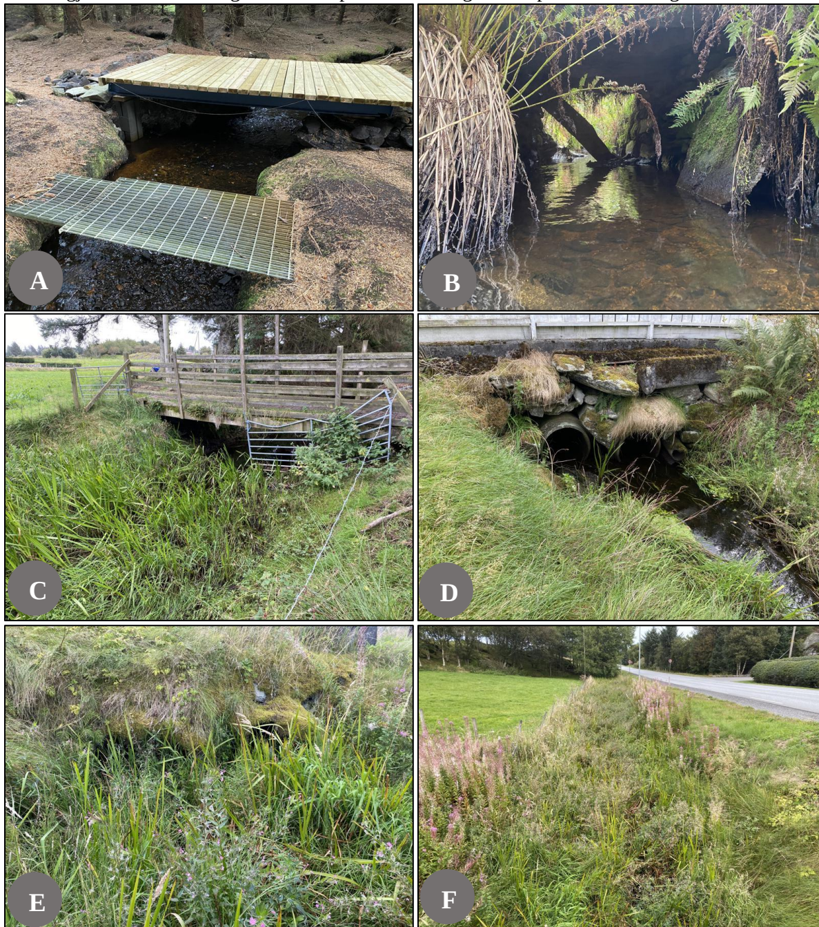
Figur 53. Bekkelukkinger og absolutt vandringshindre i Mannesbekken. A) Broer med naturlig bunn øverst av segment 5. Rett oppstrøms trebroa deler bekken seg i to, hvor sidebekken har for lav vannføring til å være fiskeførende. B) Bekkelukking av stein med naturlig bunn i segment 8. C) Trebro i segment 10 rett nedstrøms en tørrlagt sidebekk. D) Bekkelukking under bilvei i segment 11. E) Bekkelukking under bilvei i segment 13. Selve rørene har god passasje, men det er mye begroing i bekken som gjør oppvandring krevende for anadrom fisk. F) Bekken er helt gjengrodd i segment 15.
