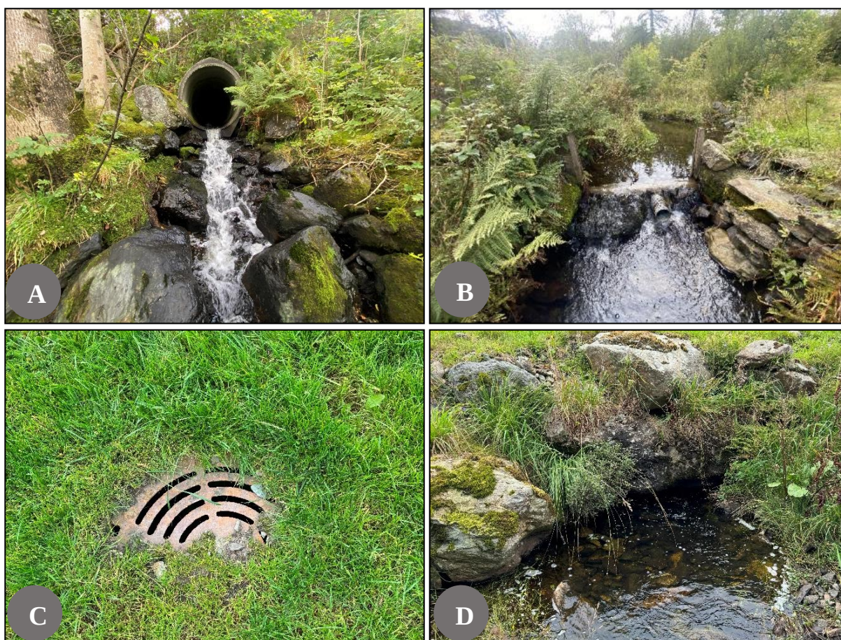
Figur 16. Kunstige vandringshindre og bekkelukkinger i Tømmervikbekken. A) Absolutt vandringshinder i form av et langt rør i segment 2. B) Betongterskel i segment 4. C) Kumlokk ca. halvveis i en 33 m lang bekkelukking mellom segment 12 og 13. D) Bekkelukking mellom segment 13 og 14. Nedstrøms åpning er en lav glipe under en stein.
