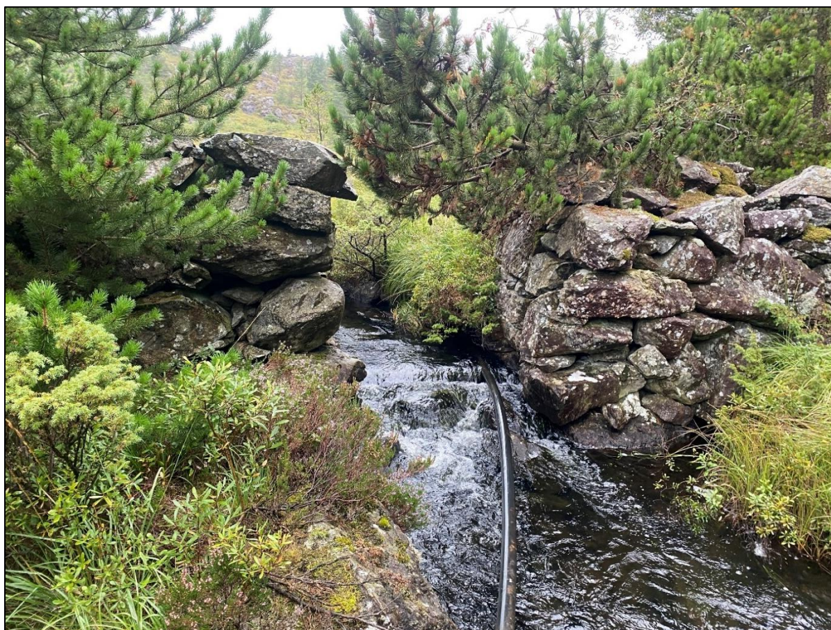
Figur 75. Rør i bekkeløp fra Kigjvatnet til absolutt vandringshinder. Bildet er tatt i utløpet av Stemmen. Som en ser, er det også en meter bred forbygning på hver side av bekken.
