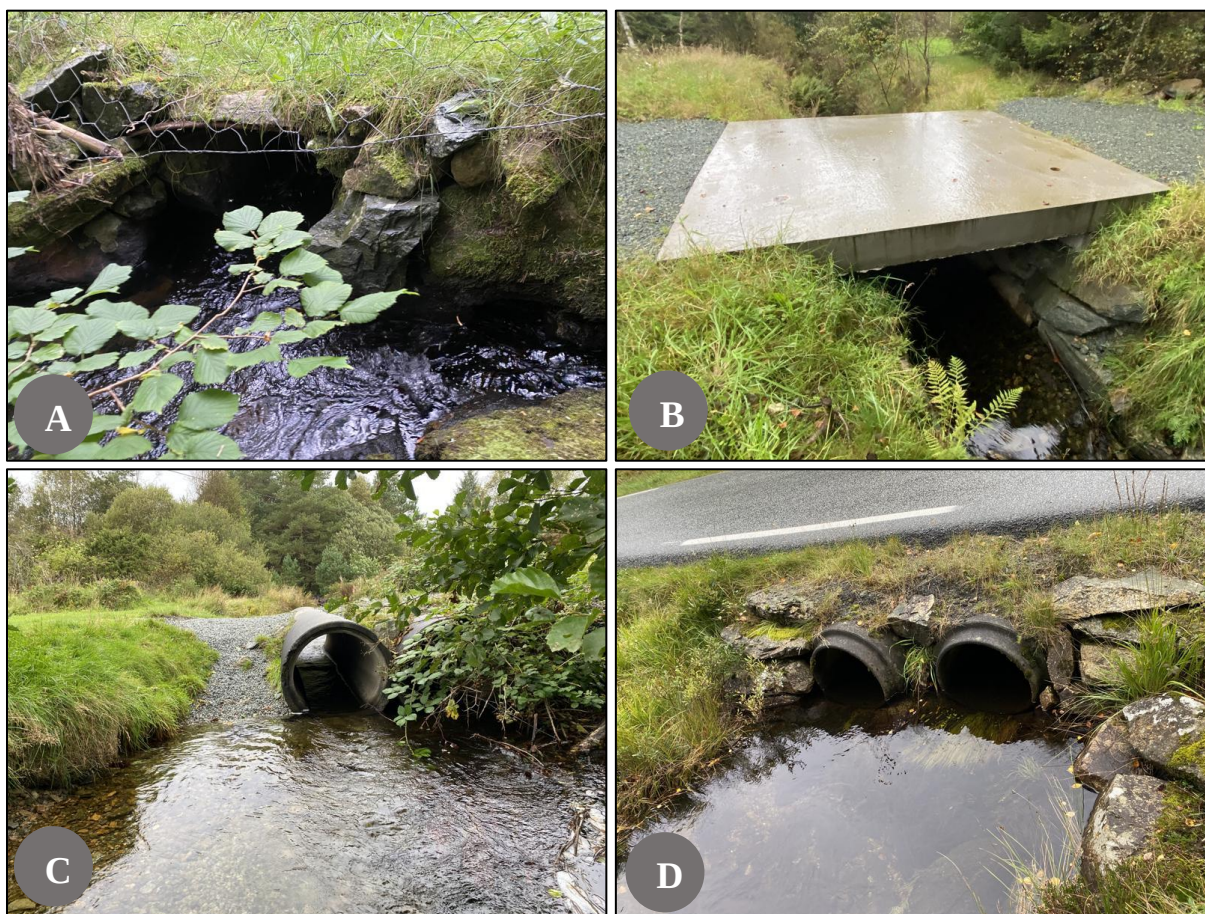
Figur 5. Kunstige vandringshindre og bekkelukkinger i Blikshavnbekken. A) Bekkelukking som utgjør et temporært vandringshinder i segment 7 grunnet opphopning av søppel/drivved. B) Ny betongbro med naturlig bunn mellom segment 8 og 9. C) Bekkelukking like ved frisbeegolfbane i segment 15. D) Bekkelukking under bilvei mellom segment 17 og 18.
