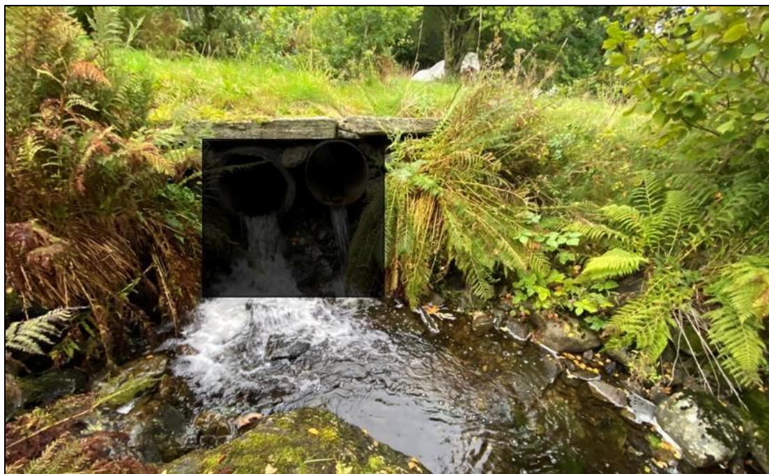
Figur 35. Illustrasjon av anbefalt endring på bekkelukkingen i segment 4. En større åpning som ligger lavere i bekken vil gjøre det lettere for anadrom fisk å passere.
