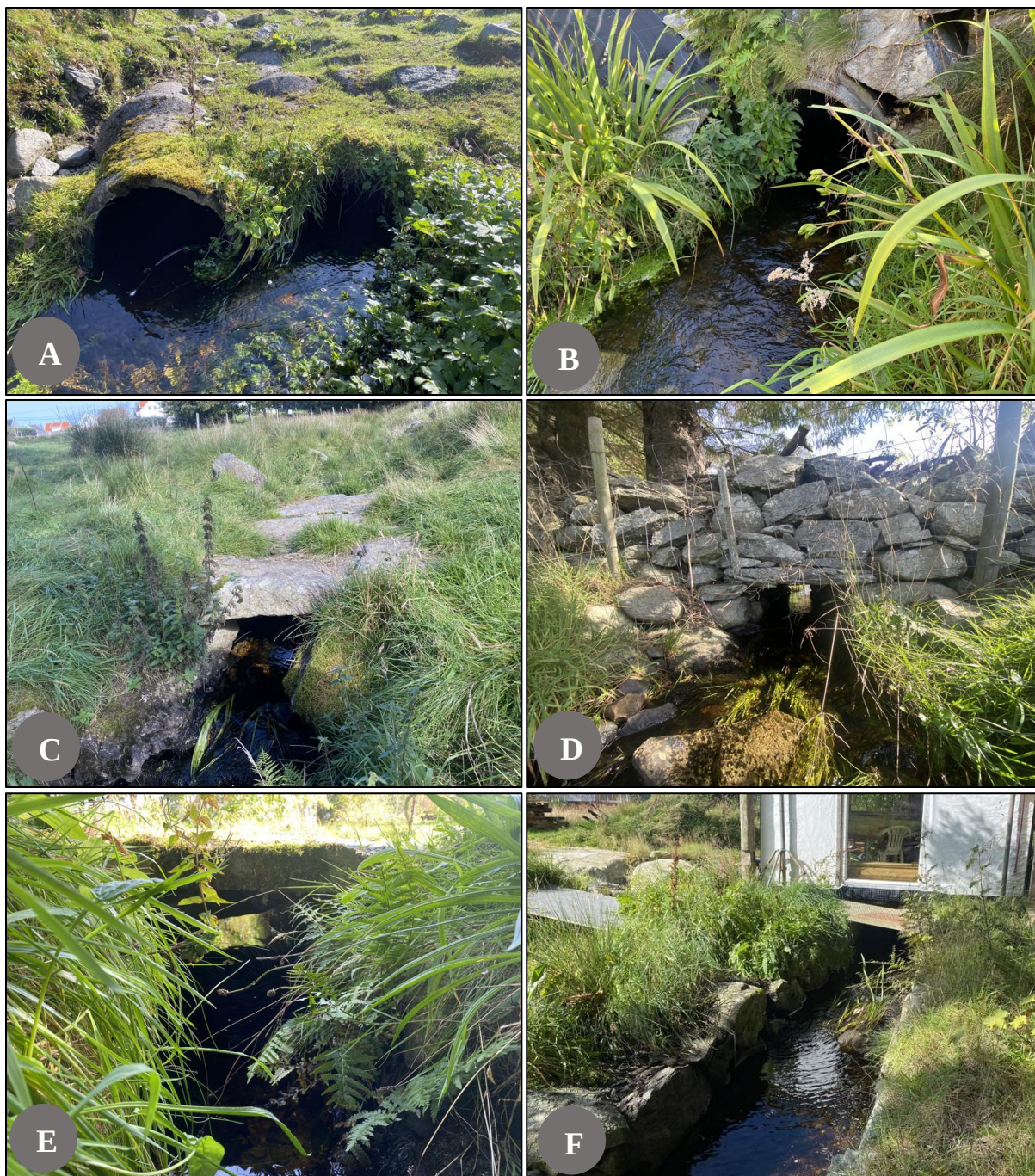
Figur 61. Bekkelukkinger i Varnebekken. A) Bekkelukking mellom segment 3 og 4 som går under Nylandsvegen. B) Bekkelukking mellom segment 4 og 5. C) Det er en bekkelukking i form av en steinkulvert med naturlig bunn i segment 9. D) Bekken renner gjennom en åpning i en mur øverst i segment 10. E) Betongbro i segment 11. F) I segment 11 er det bygget en utestue over bekken.
