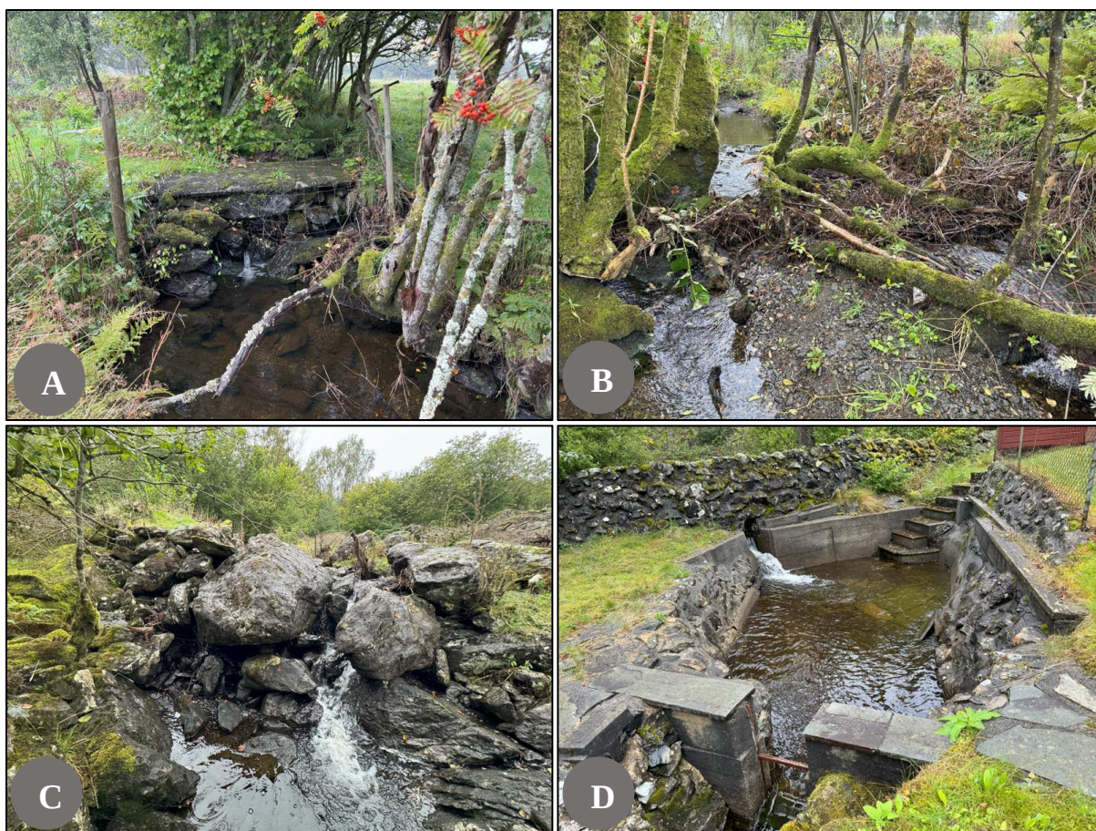
Figur 38. Kunstige vandringshindre i Stokkastrandbekken. A) Kunstig absolutt vandringshinder i form av en bro i segment 5. B) I segment 5 var det mye hage- og hogstavfall langs og i bekken, som er nok til at det utgjør et temporært vandringshinder. C) Absolutt vandringshinder i segment 12. Flere store blokker i vannløpet og trange vannløp gjør det umulig å passere mellom dem. D) Steinbasseng på ca. 18 m 2 i segment 12 med plastret bunn og betongvegger med grove steiner. Bekken kommer inn i bassenget via en liten åpning i muren på ca. 15 cm med et 1 m fall. Hullet i muren utgjør et absolutt vandringshinder.
