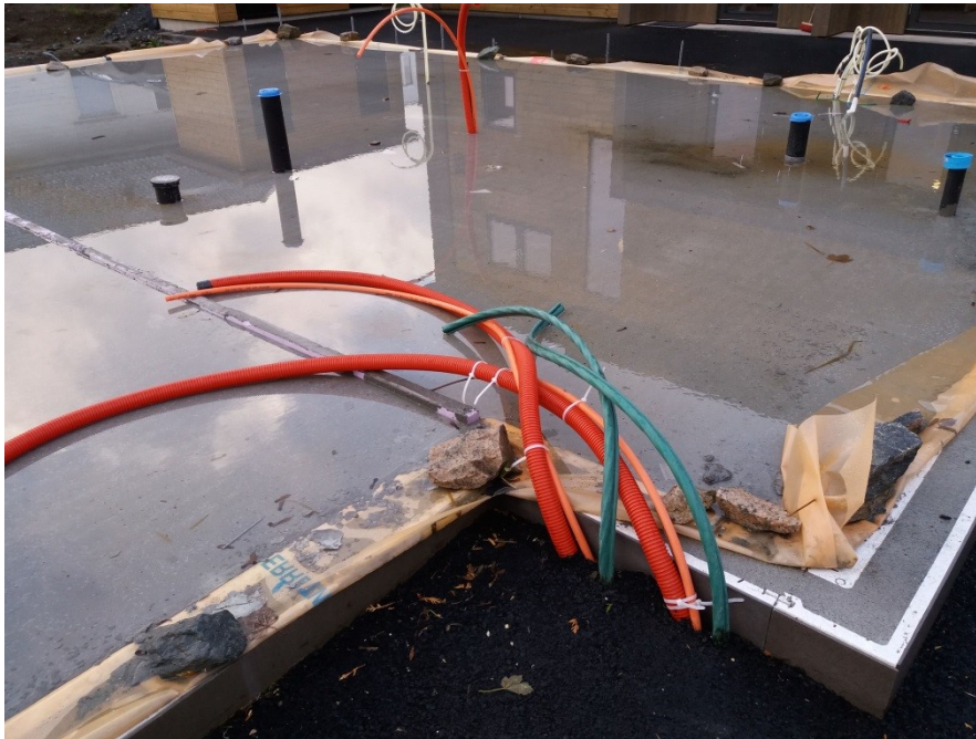
Tilsyn med grunnarbeider og muring.
